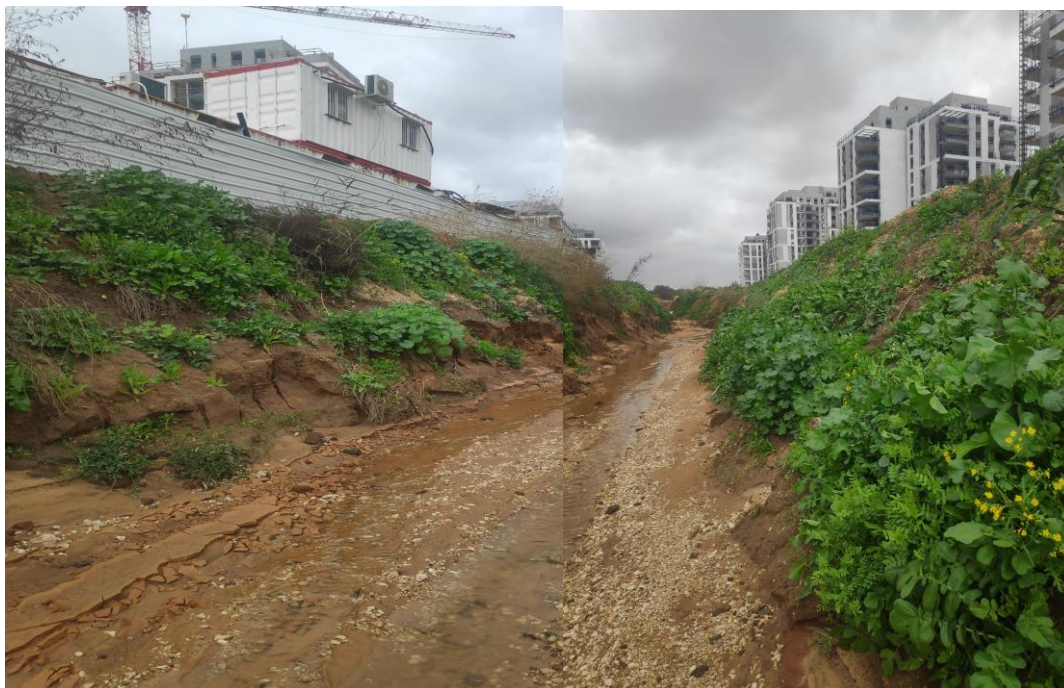
תמונה 8: אתר בנייה בית בפארק. מימין: גדה יציבה (שיפועים וכיסוי צמחיה מספקים). משמאל: גדה לא יציבה הסובלת מסחף. מקור: אורי שפר 2021
