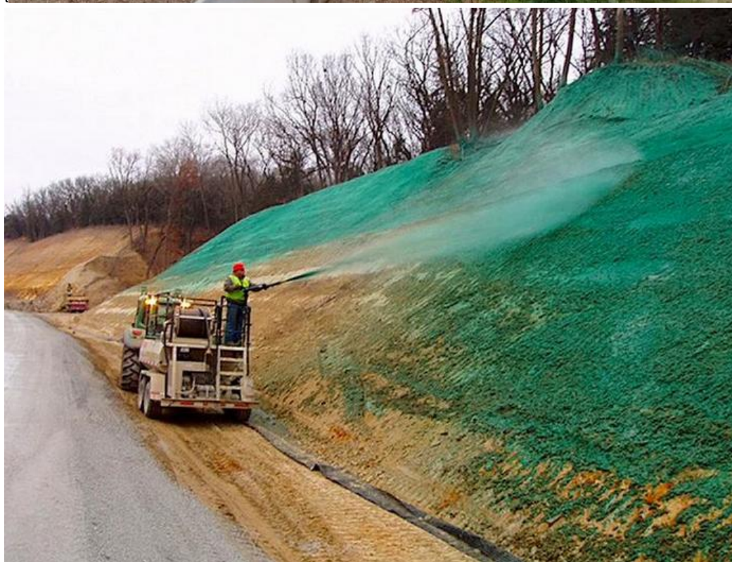
תמונות 4: דוגמאות לזריעה בהתזה מקורות: הידרוסיידנג מלזיה , טורקוגולפ
